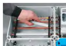
Изолирующий кожух для токоведущих шин
