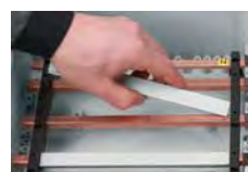
Изолирующие крышки на токоведущие шины для защиты от прикосновения
