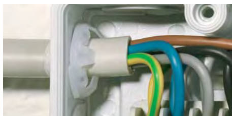
Фиксация кабеля с помощью фиксаторов KНР
