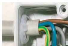
Фиксация кабеля с помощью фиксаторов KHR
