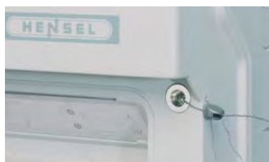
Пломбирование верхней и нижней части боксов KV
