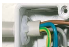
Фиксация кабеля с помощью фиксаторов KHR
